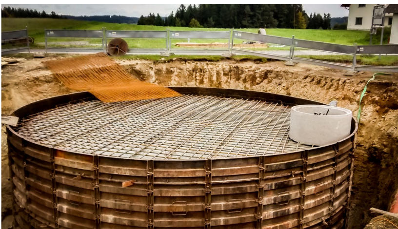
Löschwasserbehälter „Ebened“ in Bau
