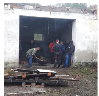
Kameraden nach dem praktischen Schulungsteil - Abtrag von einsturzgefährdeten Dachstuhl.
